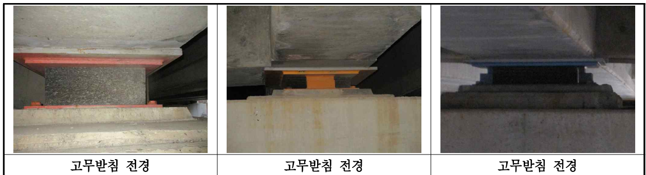
【사진 18.3.35】 교량반침 전경
