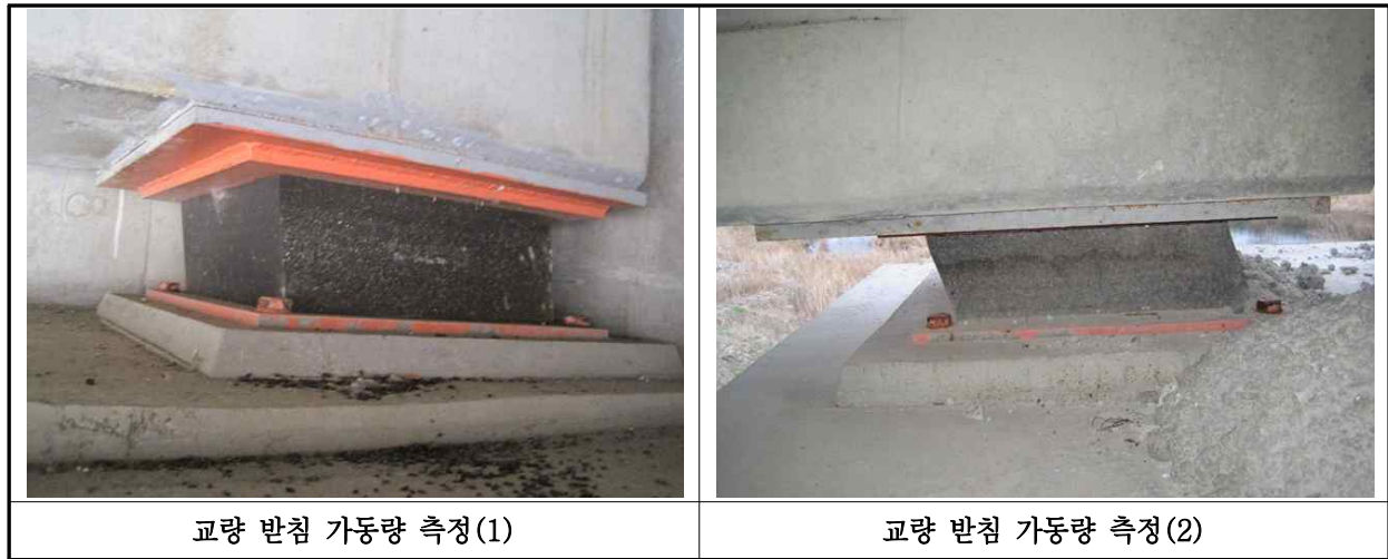
【사진 18.3.38】 교량받침 이동량 측정
