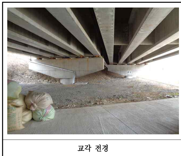
【사진 18.3.33】 교각 전경
