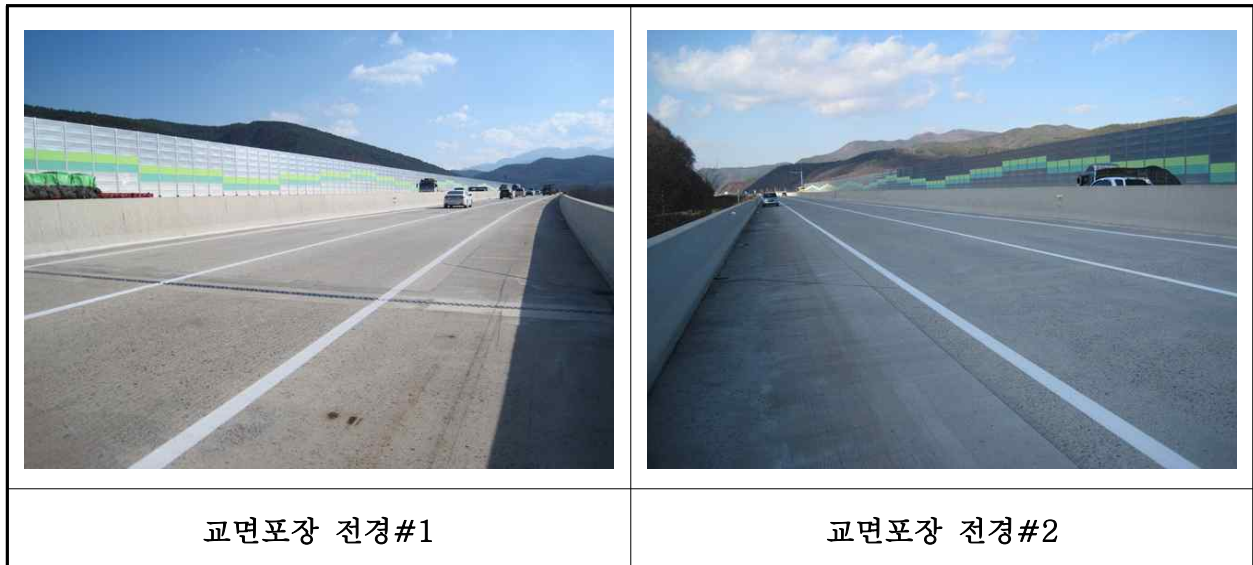
【사진 18.3.42】 교면포장 전경
