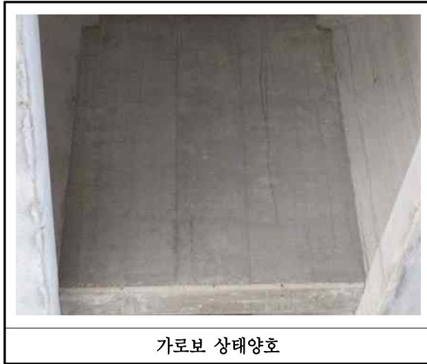
【사진 18.3.30】 가로보 손상현황
