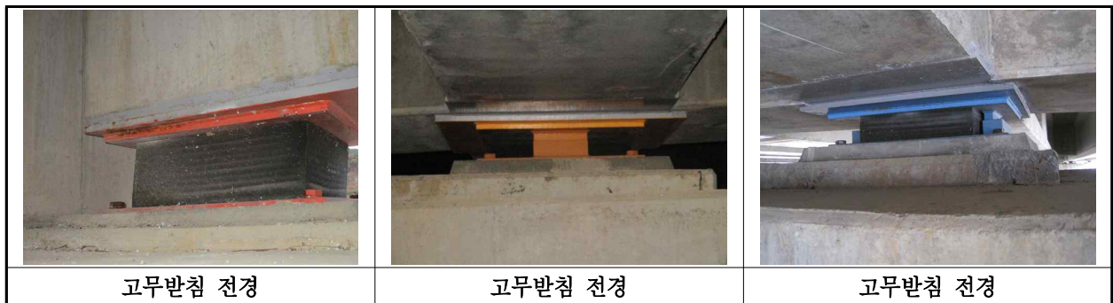
【사진 18.3.12】 교량반침 전경
