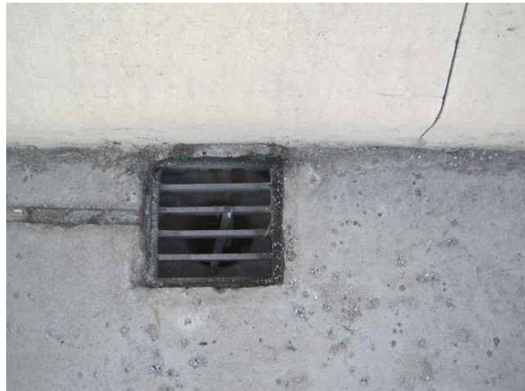
배수시설 상태 양호
