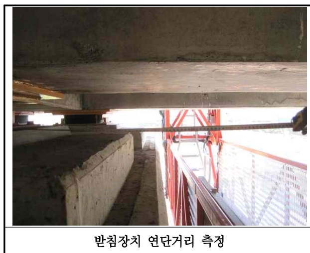
【사진 18.3.14】 교량받침장치 연단거리측정
