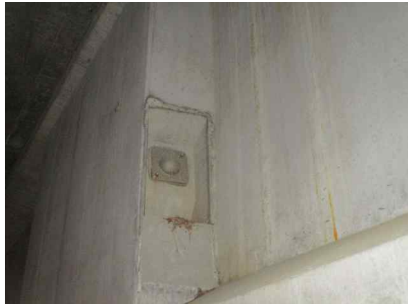
거더 정착부 상태양호
