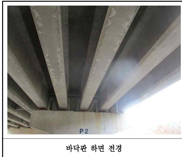
【사진 18.3.2】바닥판하면 전경
