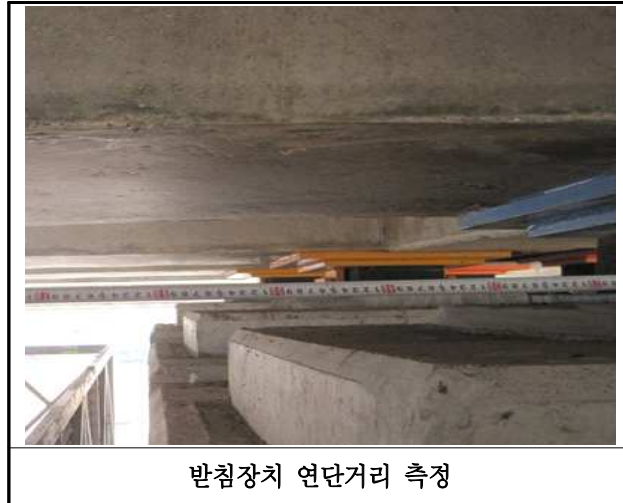
【사진 18.3.37】교량받침장치 연단거리측정
