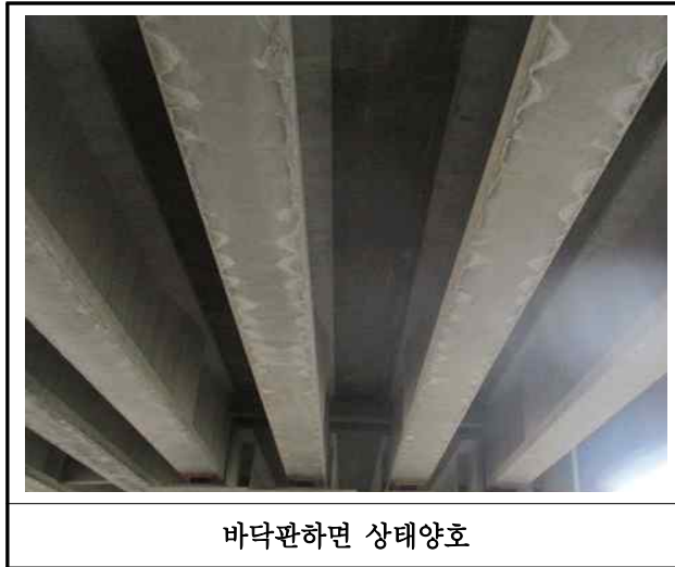
【사진 18.3.3】 바닥판하면 손상현황
