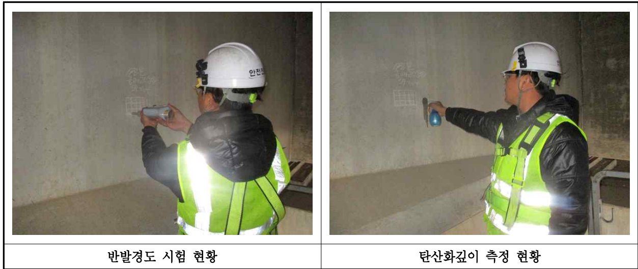
【사진 18.4.1】 콘크리트 내구성조사 현황
