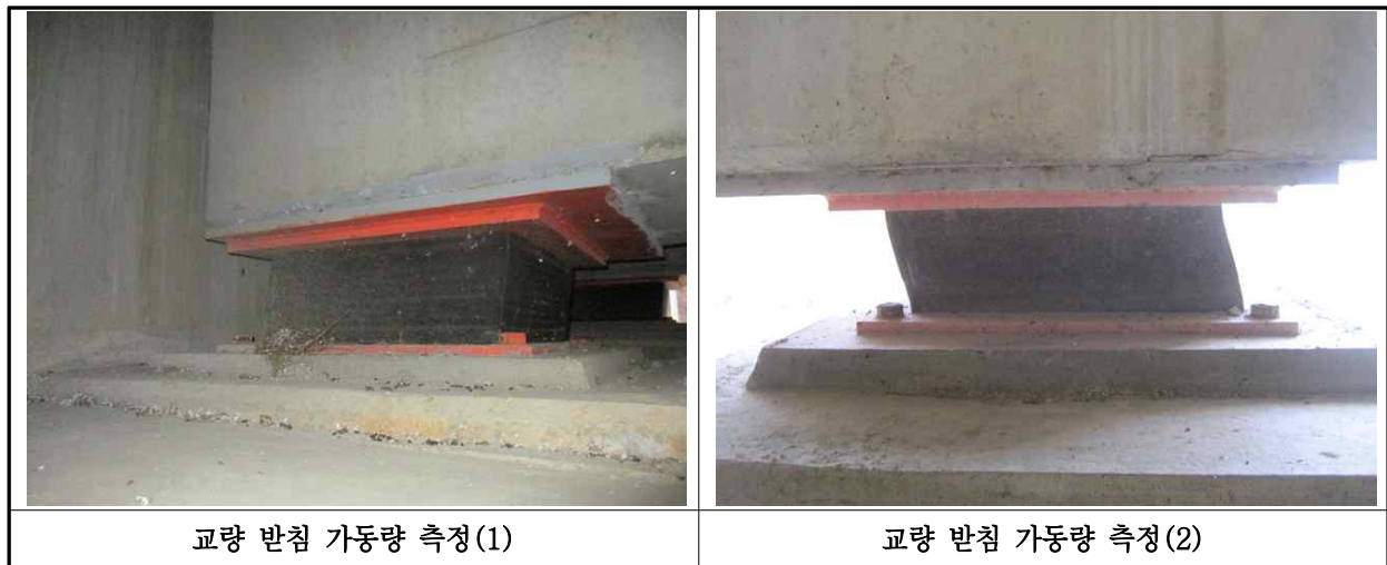
【사진 18.3.15】 교량받침 이동량 측정
