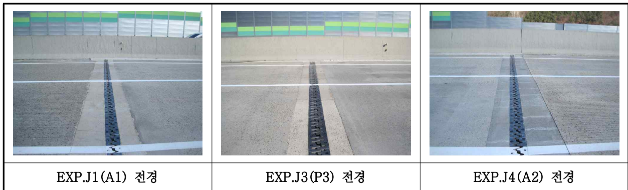
【사진 18.3.39】 신축이음장치 전경
