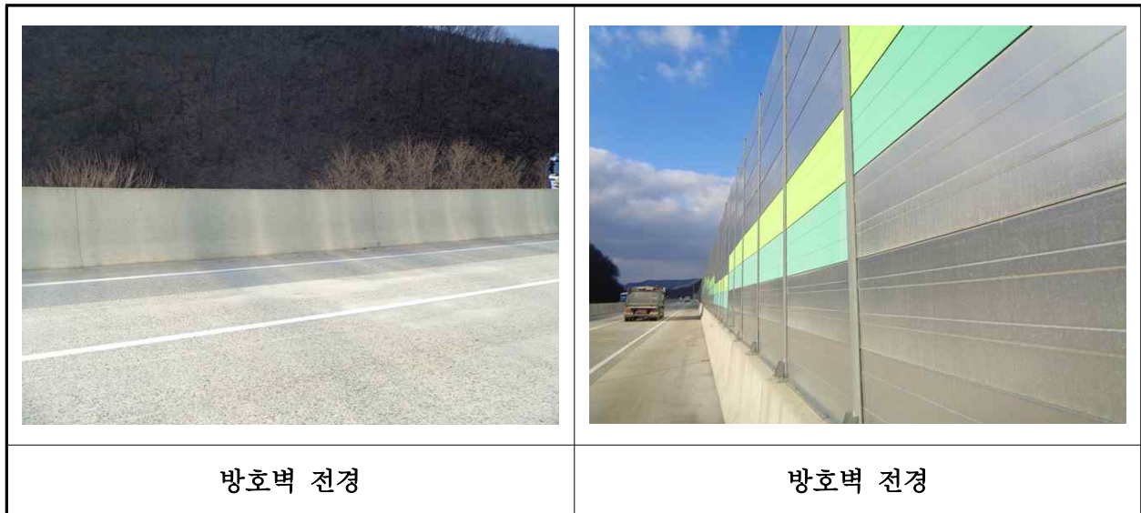
【사진 18.3.23】 방호벽 및 중앙분리대 전경
