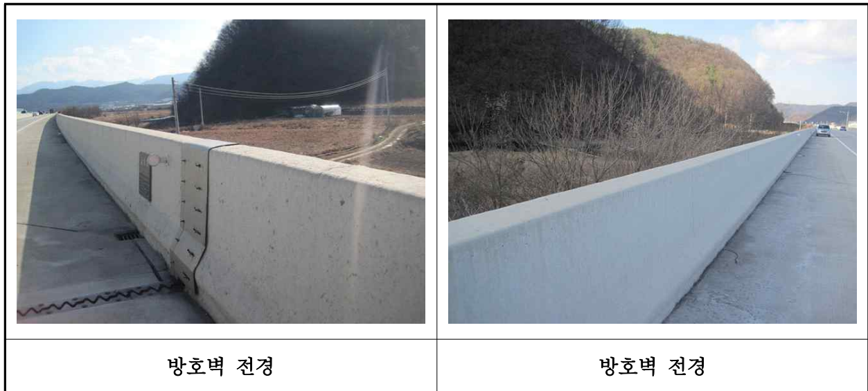
【사진 18.3.46】 방호벽 및 중앙분리대 전경
